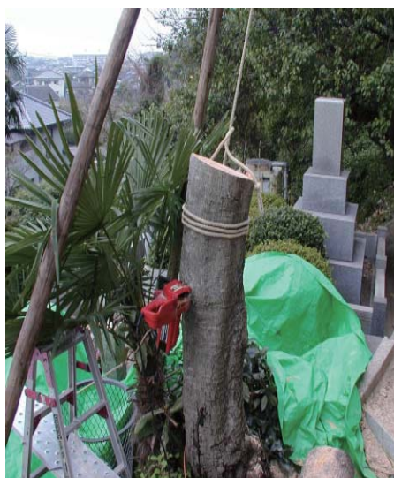
墓地内の枯れ木の伐採
