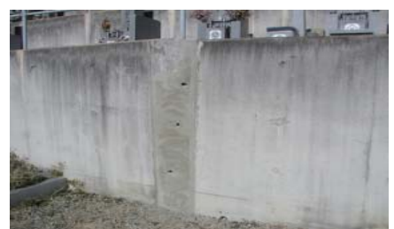
擁壁亀裂部の修復工事（上）・工事完了（下）
