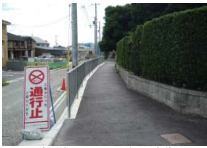
廟所前のリニューアルされた歩道
