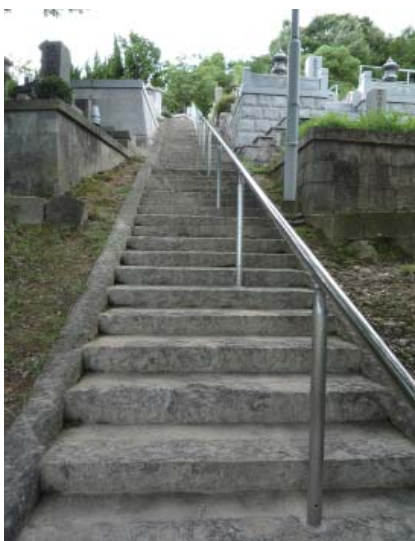
老百八階段の手摺の設置
