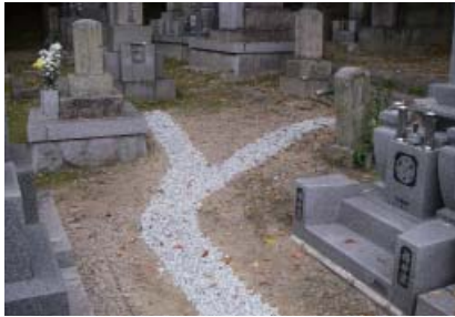
湧水誘導の透水管の敷設工事
