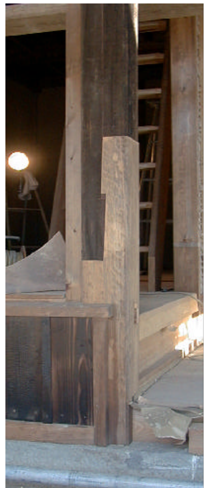
古材を出来るだけ生かすために老朽化した部分のみを新しくして組立てている。太鼓楼西面柱部。
