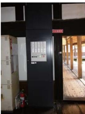
この自動火災警報装置は24時間火災の危険を知らせてくれる。文化財に指定されて以来、設置が義務づけられている。毎年消防署の査察と防火訓練が実施される。最近、落雷によって装置が破損し、新しい装置が設置された。この費用はお寺からの出費もままならない。
