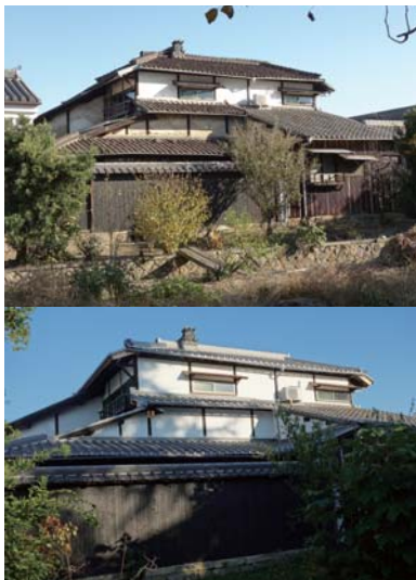
北書院二階部の修理前後／北書院の西端にあたり後から追加的に建設されたと言われている。2022年の屋根替えで修理された。
