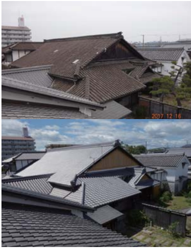
北書院全景／本願寺朴子入寺にあたり建設・入母屋で本瓦葺三方下屋を設け西端に二階部を設ける・2023年の屋根替えで棧瓦葺きに替えられた。
