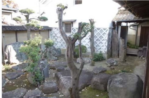
北書院石庭／数年来、手入れのないまま放置された状態である。大型の石が取り入れられ北書院の裏庭として造られたものである。
