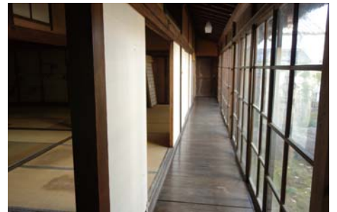
北書院内部／ガラス戸をもつ廊下が周囲にあり、内を隔てて二階部が設けられている。廊下は五〇八㎡・一五七坪）敷台と敷居をもつ玄関、仏間を中心とした客間、寝室、台所二箇所、茶室と水屋、納戸、お付きの控室、女中部屋を内包し、各部屋
