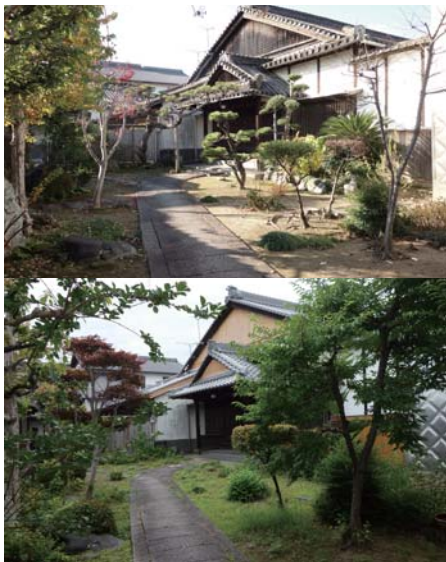
北書院玄関部／2023年の屋根替え時に修理された・中の門から石畳に誘導され玄関に繋がる
